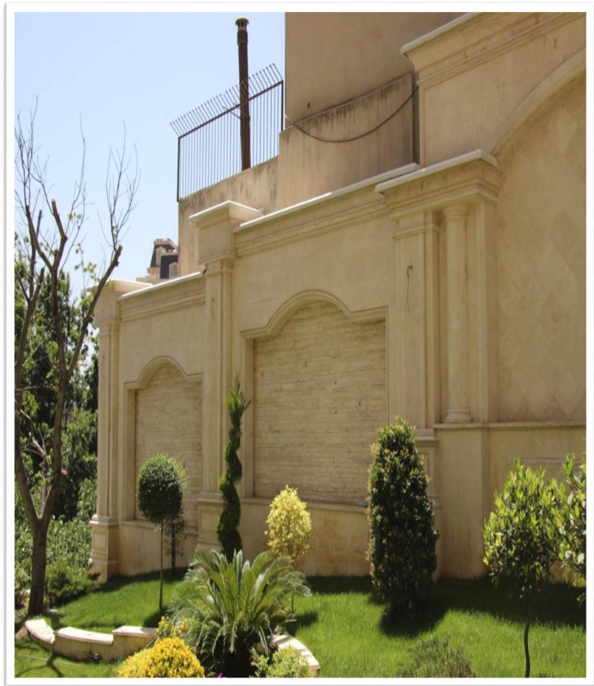
سنگ تراورتن آتشکوه اجرا شده در پروژه گلابدره
